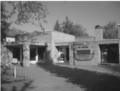
Wer in diesen Tagen an der Breslauer Straße entlang geht, kann sich sofort selbst überzeugen: Der Umbau der „Arche“ schreitet voran. Besonders offensichtlich sind die Abgrabungen rund um das Ge-
